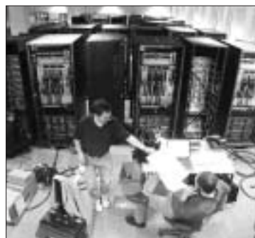
IBM-Techniker während der Installationsarbeiten im Rechenzentrum Fotos: Hassan Mahramzadeh
